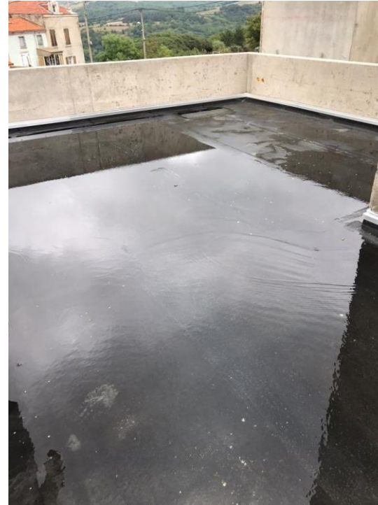
Eau stagnante sur toiture à pente nulle
