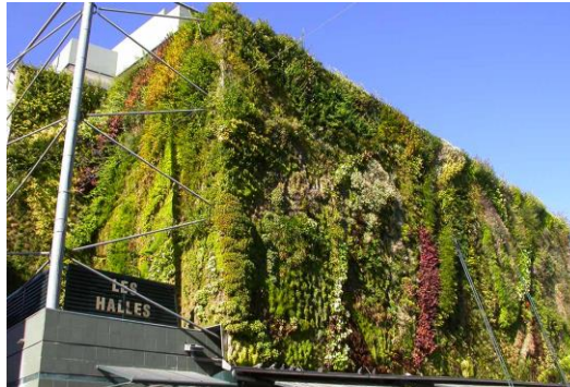
Mur végétal sur le bâtiment des Halles de la place Pie – Avignon. Paysagiste: Edouard François
